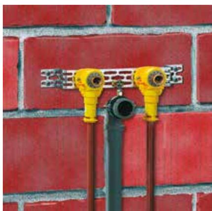
Installation de lavabo : Montage parfaitement ajusté
